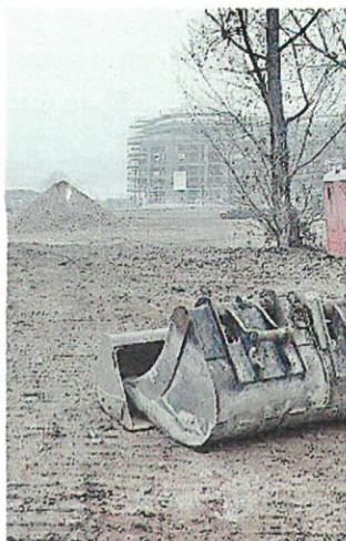
I lavori per la rotatoria
